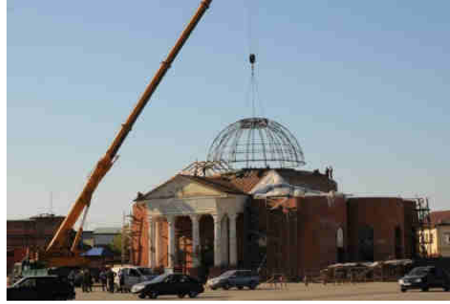
Рис. 4. Монтаж купола церкви Рождества Пресвятой Богородицы, г. Киров
