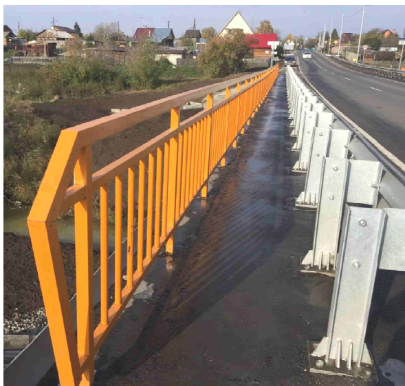
Рис. 1. Дорожные ограждения на мостовом переходе
