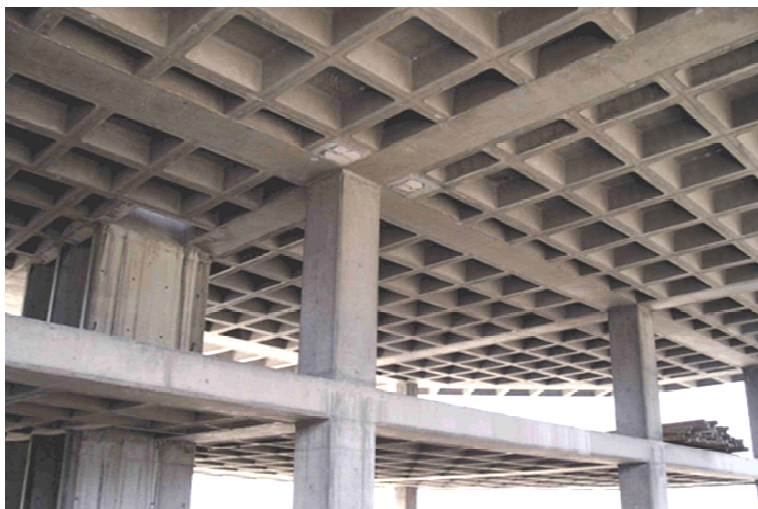
Рис. 2. Перекрытия кессонного типа
