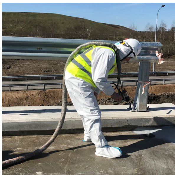
Рис. 4. Нанесение слоя гидроизоляции Fig. 4. Applying a waterproofing layer
