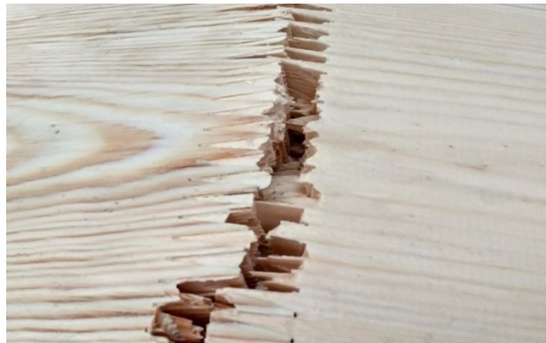
Рис. 4. Характерное разрушение в зоне зубчатого соединения при отсутствии дефектов и качественном нанесении клея
