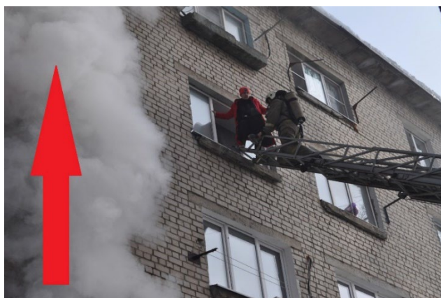
Рис. 1. Пример распространения пламени по фасаду МКД
